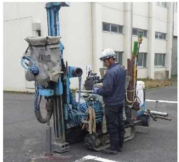
ボーリングによる試料採取
